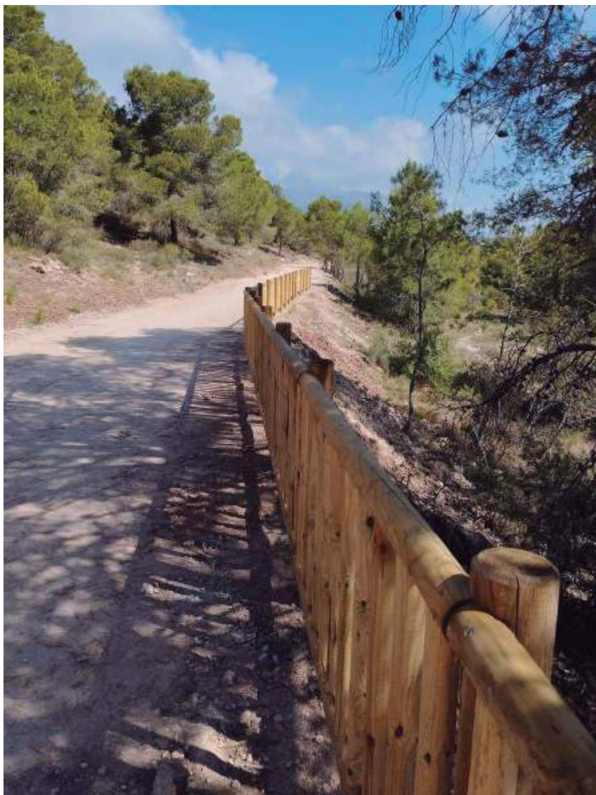
Fotografía nº8: Zona de talanquera entre los nudos C26 y N14 que es preciso prolongar para proteger el desnivel existente (75 ml incluidos en el presente proyecto).
