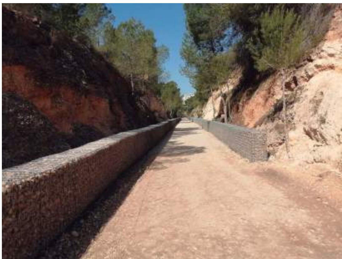
Fotografía nº1: Zona de trinchera en trazado de antigua fía del ferrocarril.
