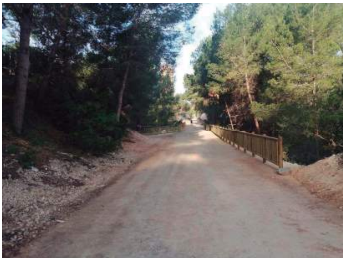
Fotografía nº3: Ídem fotografía anterior, pero en zona de terraplén (sobre cauce del Barranco de Xixo).
